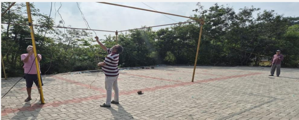
Rigging the Fan Dipole
